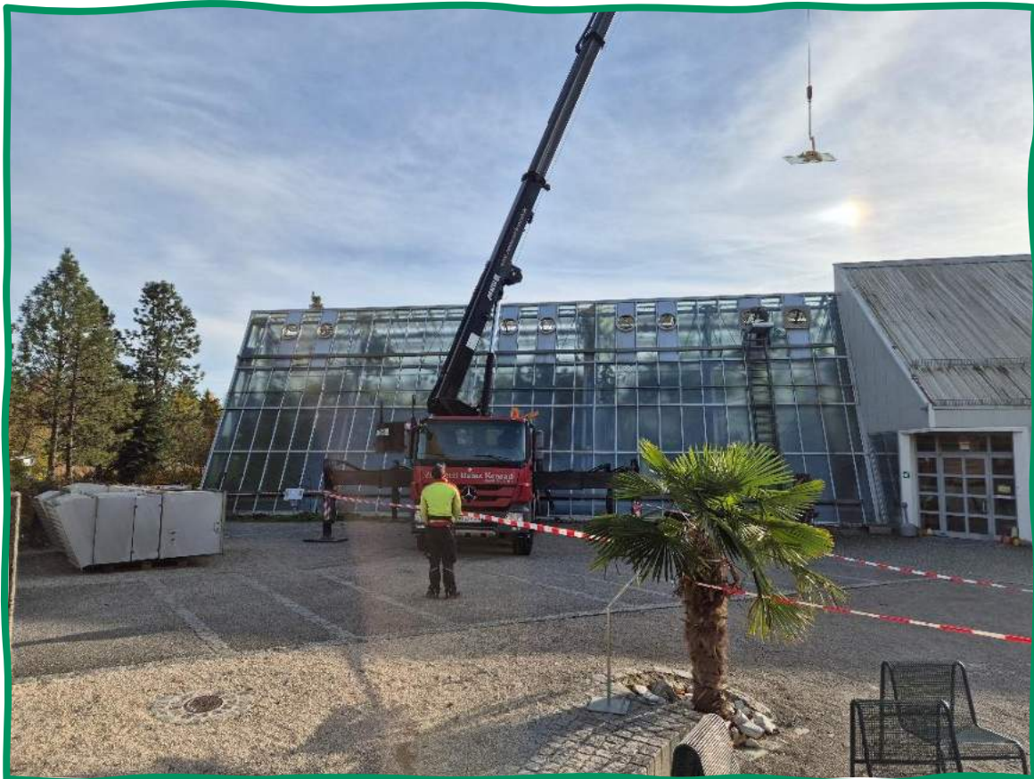
Abb. 45: Austausch von defekten Glasscheiben in den Schaugewächshäusern im Oktober 2025 (Foto: Heike Schwarzer)
