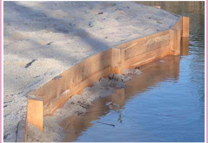
Die fertige Uferbefestigung aus dem Holz unserer Zedern. Foto: © G. Aas
