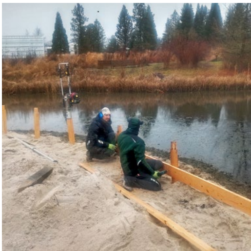
Abb. 23: Die fertige Uferbefestigung aus dem Holz von Zedern aus dem ÖBG (oben).
